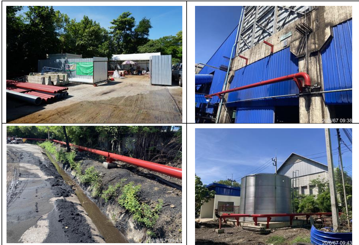
รูปที่ 1.5-2 : การติดตั้งอุปกรณ์แจ้งเตือนและระบบอัคคีภัย
